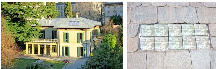
*Figura 3 – Alternative progettuali per la copertura proposta alla Soprintendenza (©Valentina Cari)*
