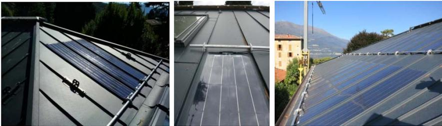
Figura 7 - Dettaglio della copertura e del pannello fotovoltaico (© Myriam Perna e Valentina Cari)
